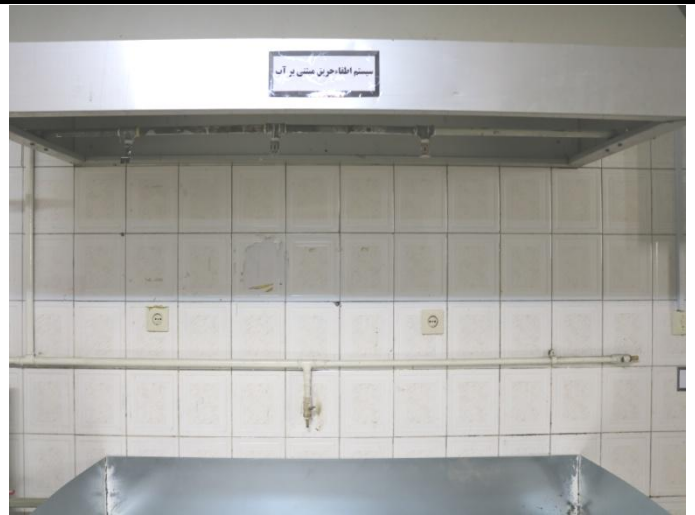
سیستم اطفاء حریق مبتنی بر آب
